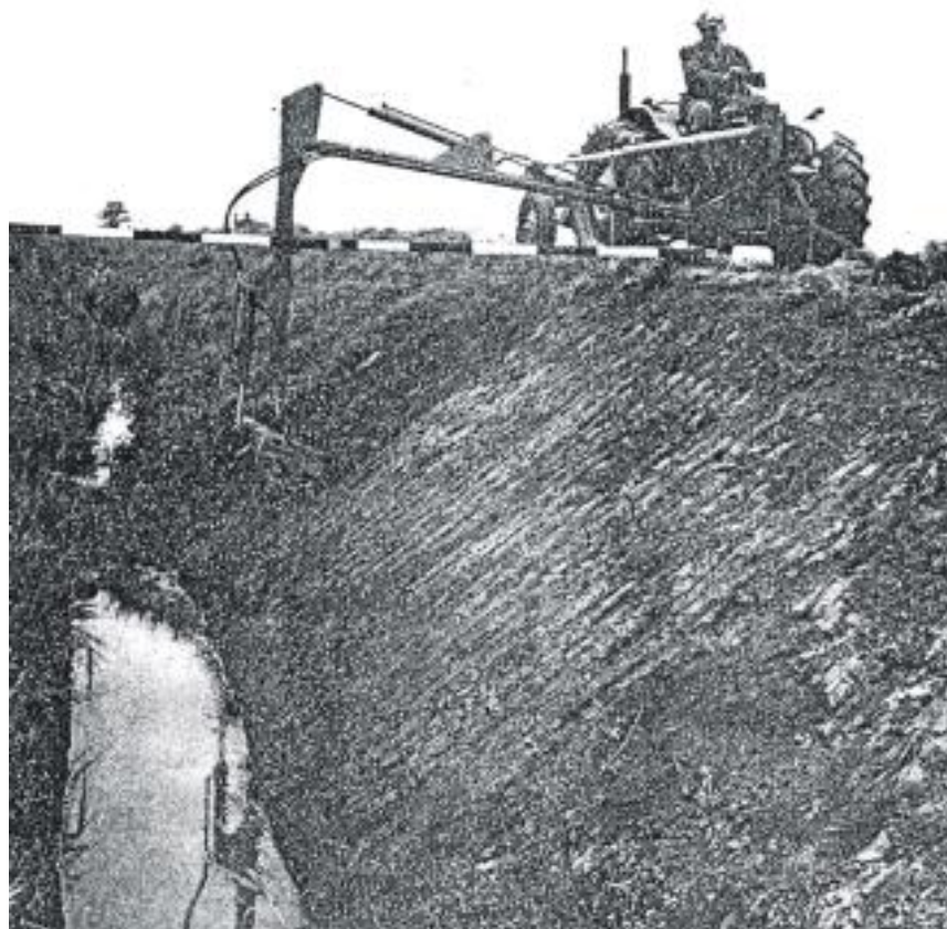
Fig. 128.9. Limpieza de una zanja utilizando medios mecánicos.
