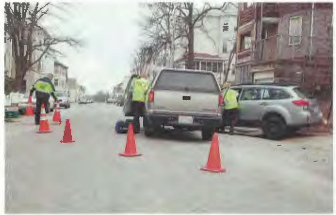
Figura 6-4 Colocación de los instrumentos para delinear el tránsito. Fuente: © Jones & Bartlett Learning. Fotografía de Darren Stahlman.
